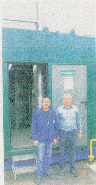
Jürgen Schmalzhaf und Rüdiger Heiche (rechts) vor dem neuen BHKW. Foto: Paul
